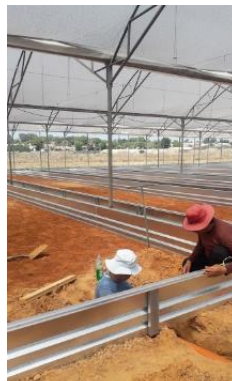
תמונה 5: בניית הבריכות, קירוי הבריכה, ריפודה וכיסויה ביריעת פוליאתילן
