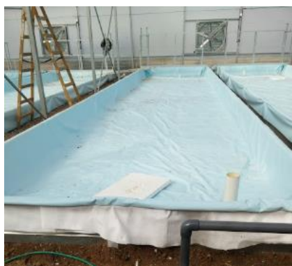
תמונה 5: בניית הבריכות, קירוי הבריכה, ריפודה וכיסויה ביריעת פוליאתילן
